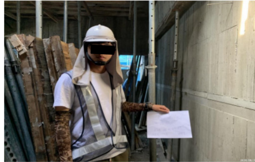
9FL(A 棟)灌漿拆模抽查(X3-4 Y3-4 柱牆模第 3 日開始拆除符合規定)
