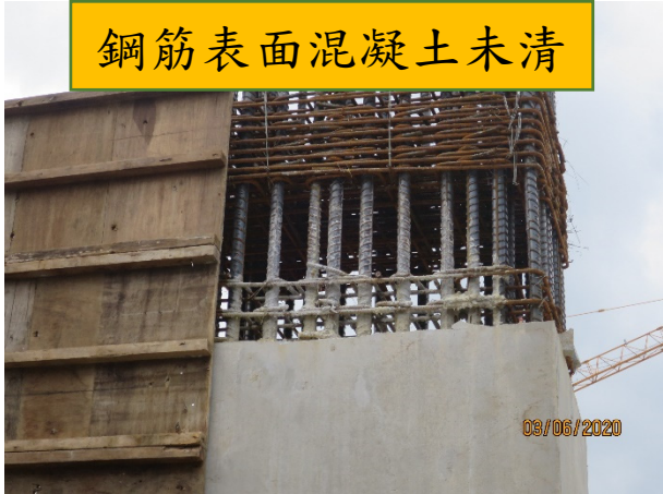
預留鋼筋保護層過大
