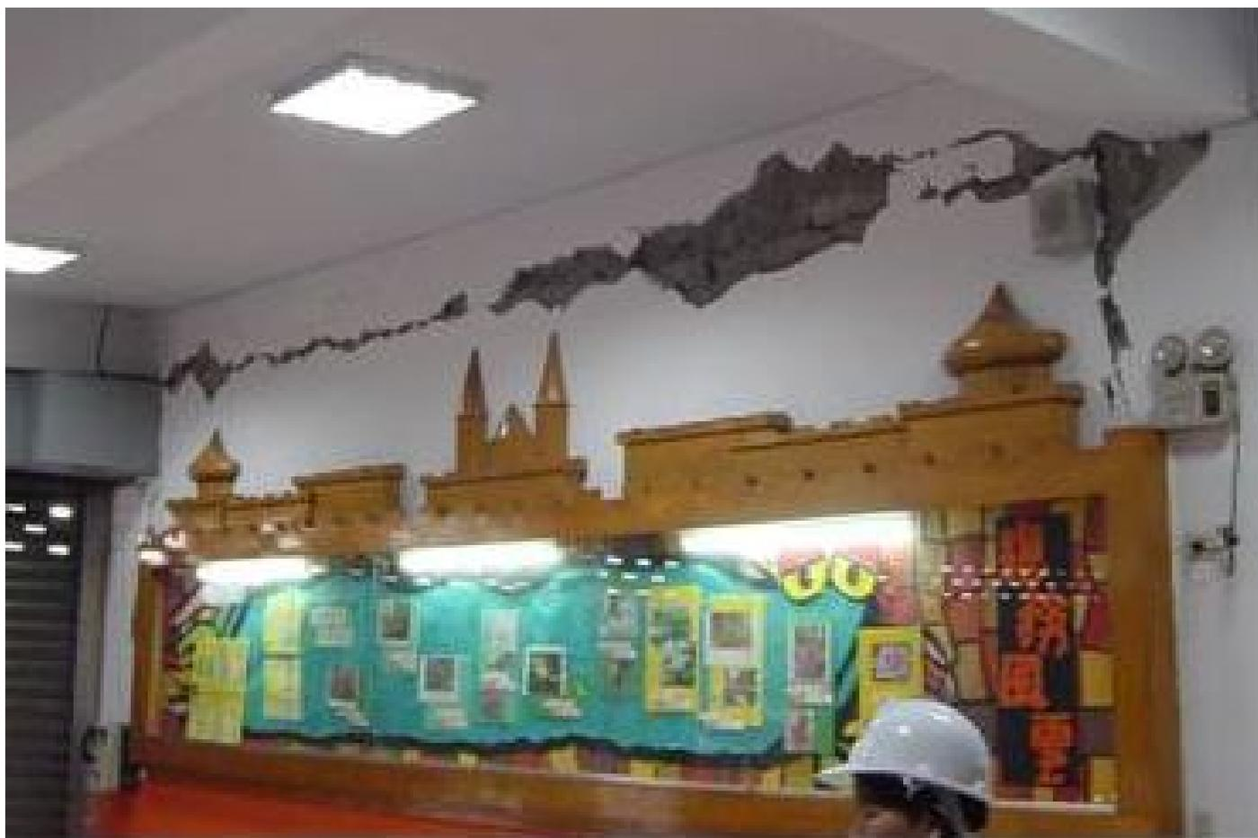
安和國小補強之剪力牆於311地震中破壞照片
