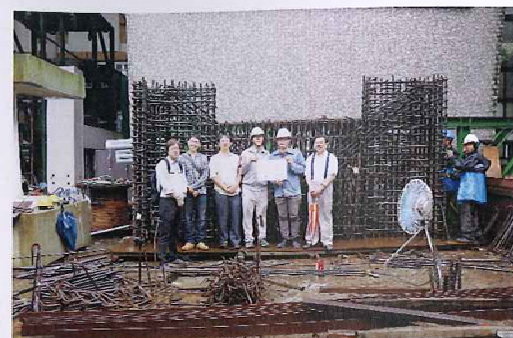
(b) 混凝土梁柱鋼筋綁紮工程查驗(105/10/14)
