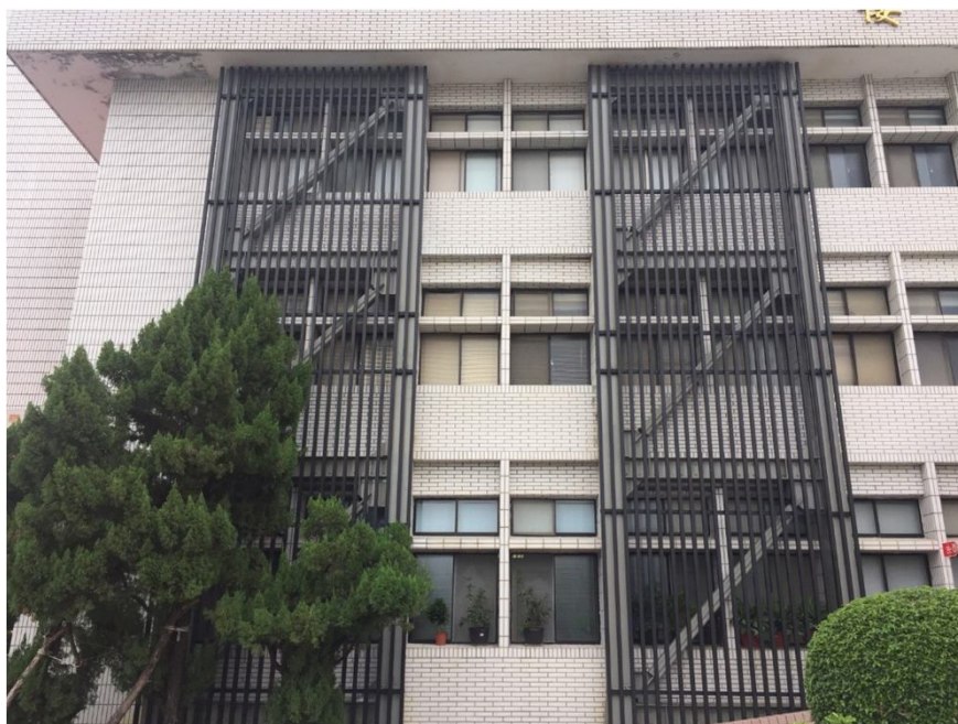
外貼式BRB鋼框+斜撐補強
