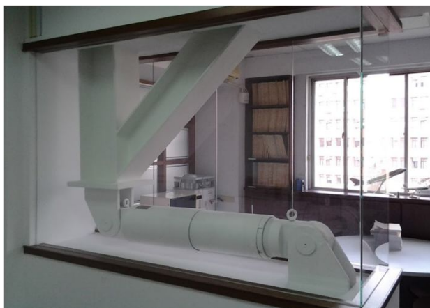
液流阻尼器內部補強
