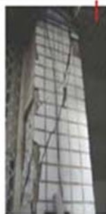
勘災結果：柱發生剪力破壞(一根嚴重破壞，其他柱多處剪力裂縫)
