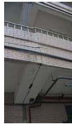
勘災結果：露棟伸縮縫破壞
